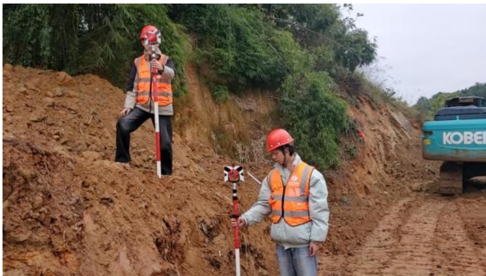
（图 27：《工程测量》课程边坡放线实地操作）
